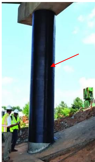
รูปที่ 7.1-3 การนำคาร์บอนไฟเบอร์พันรอบหน้าตัดเสา
