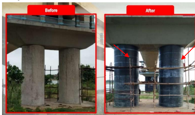
รูปที่ 7.1-4 ตัวอย่างของการเสริมกำลังของเสา
