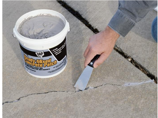
รูปที่ 7.1-1 การฉาบปะ (Patching)
