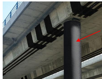
รูปที่ 7.1-2 การนำ CFRP Wrap เสริมใต้ท้องคานและพันรอบหน้าตัดเสา
