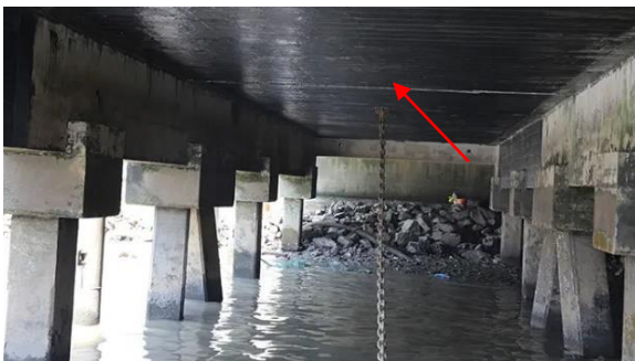
รูปที่ 7.1-2 การนำ CFRP Wrap เสริมใต้ท้องคานและพันรอบหน้าตัดเสา
