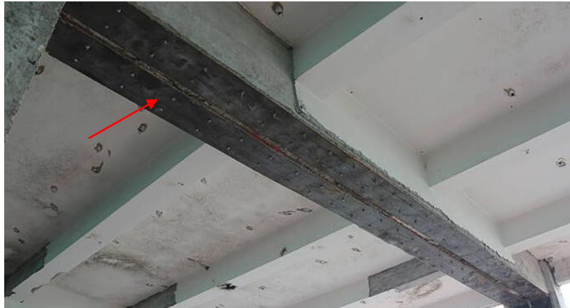
รูปที่ 7.2-5 การเสริมกำลังหน้าตัดโครงสร้างสะพาน โดยใช้ Steel Plate
