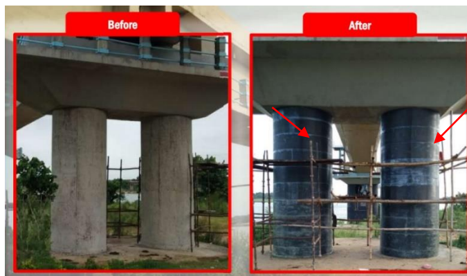
รูปที่ 7.2-4 ตัวอย่างของการเสริมกำลังของเสา
