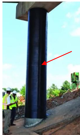
รูปที่ 7.2-3 การนำคาร์บอนไฟเบอร์พันรอบหน้าตัดเสา
