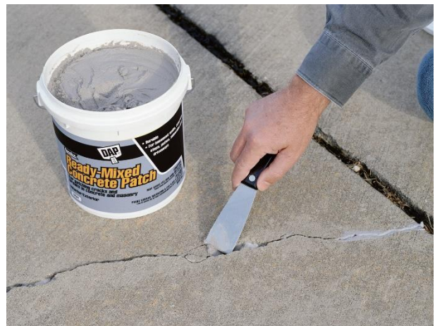
รูปที่ 7.2-1 การฉาบปะ (Patching)
